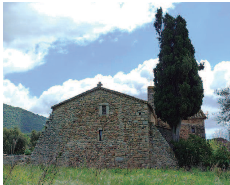
Aquest costat de l'església de Santa Maria de Bell-lloc s'ensorrà i, on hi havia hagut un segon absis, es féu una paret (2012). Foto: Jordi Gaitx Moltó. Fons de l'Ajuntament de Santa Cristina d'Aro.
